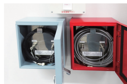
施工例 (屋内露出型 無線機接続端子箱)
